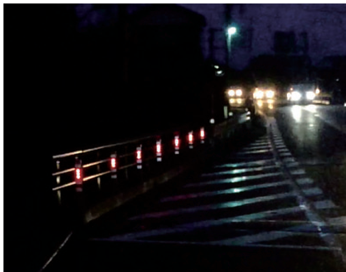
国道9号線溝川交差点付近
